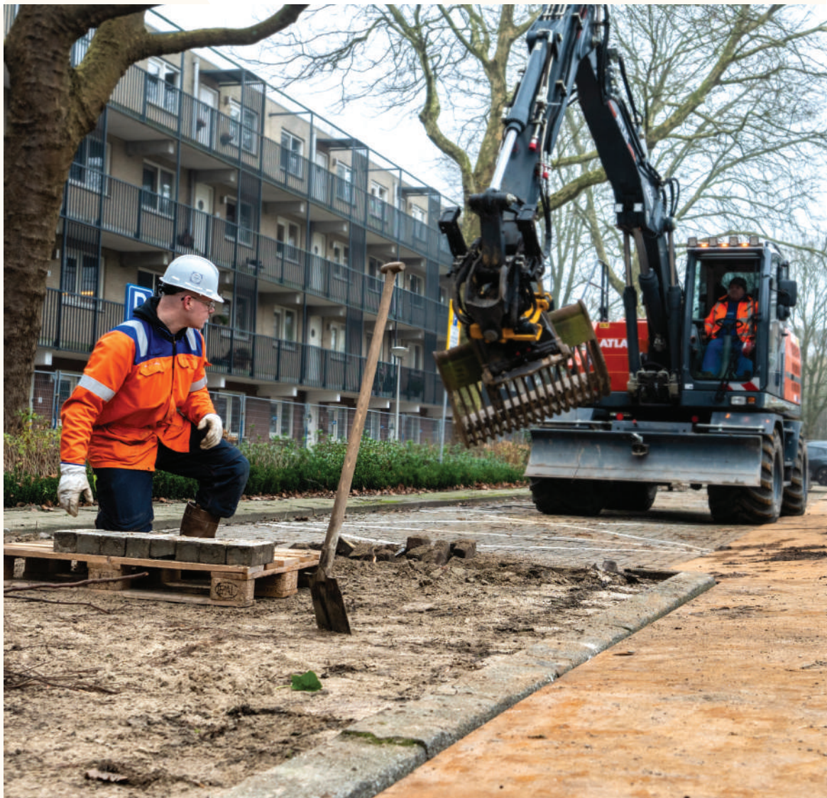
De eerste schop in de grond aan de Apolloweg
