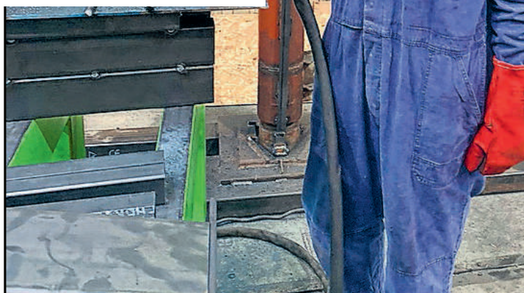
Alain’s stage was bij een kassenbouwer, hij voerde laswerkzaamheden uit
