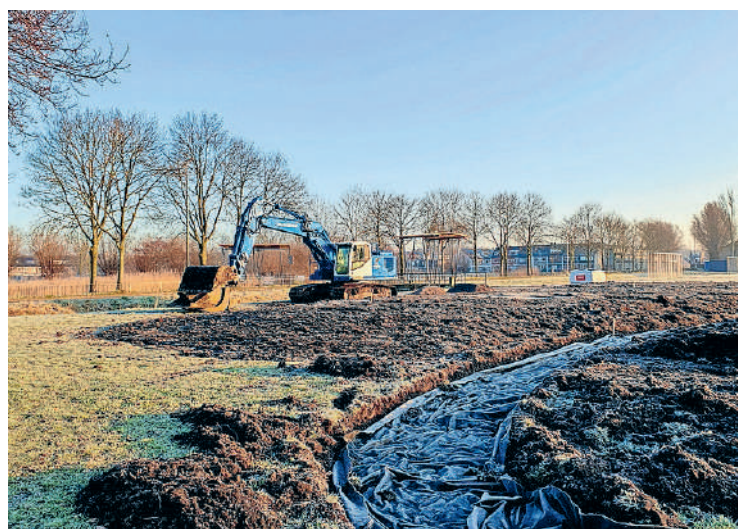
Het werk is al begonnen in de Abtswoudsepark
