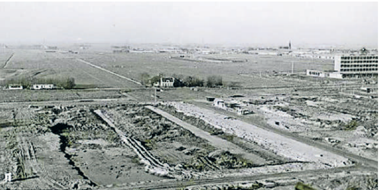
Abtswoudseweg (nu de Beatrixlaan) bij de aanleg van het Voorhof West
